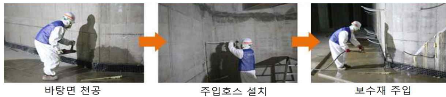
그림 4. 누수 보수공법 신기술의 시공절차 및 방법
