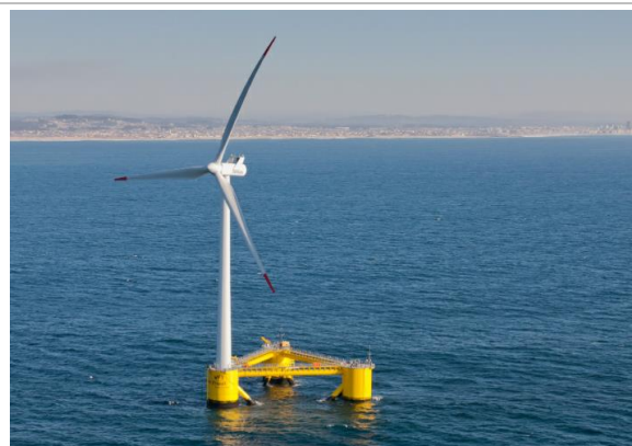
도표 82. 실제 설치된 부유식해상풍력 발전기
